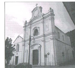
S. Maria della Libera in frazione Pandola di Mercato S. Severino (SA), con la facciata crollata per il sisma del 1981 e dopo ricostruzione nel 2005.
