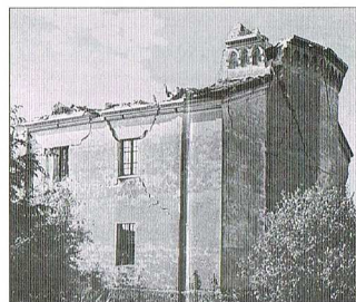
Friuli, Parrocchiale di Nimis, da questi esempi si cominciarono ad individuare i cinematismi di crollo tipici degli edifici ad aula.
